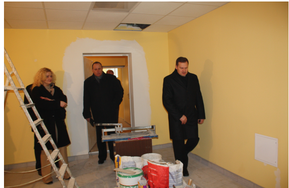
Visuomenės sveikatos biuro remontas
