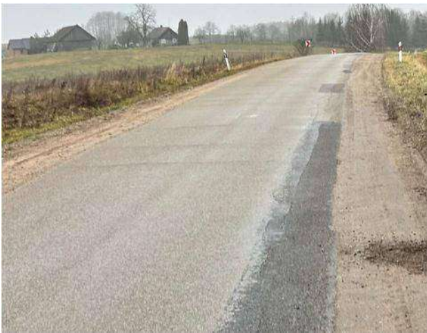
10 pav. Nutrupėję asfalto dangos kraštai
