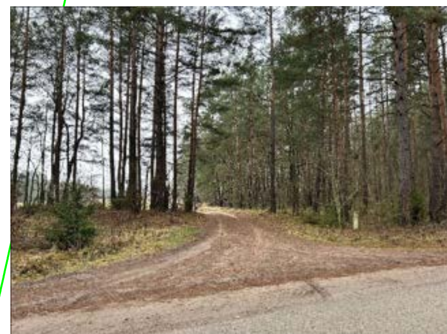
Nuovaža (pūtynė) (4p) PK 54+09 Nuovaža suvedama su esamu paviršumi. Nuovaža (pūtynė) - reģistruota statinio kadastra byļoje. Projektuojama 4p tipo nuovaža su asfaltbetonio danga.
