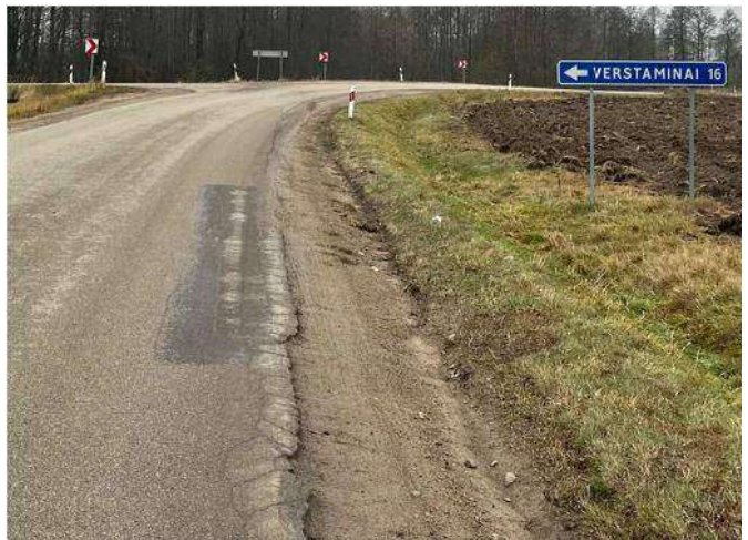
10 pav. Nutrupėję asfalto dangos kraštai
