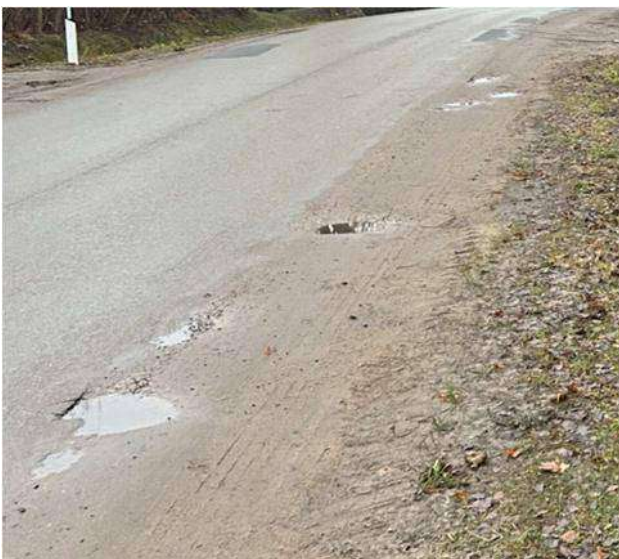
10 pav. Nutrupėję asfalto dangos kraštai
