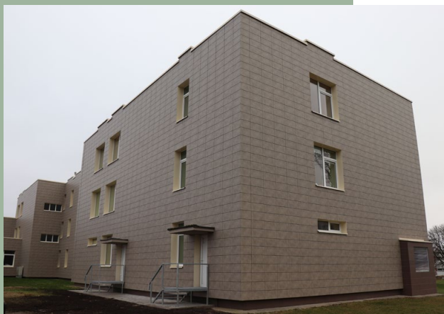
Fasadas po remonto
