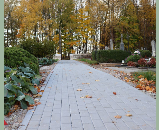
Kapinių atnaujinimo darbai Punioje
