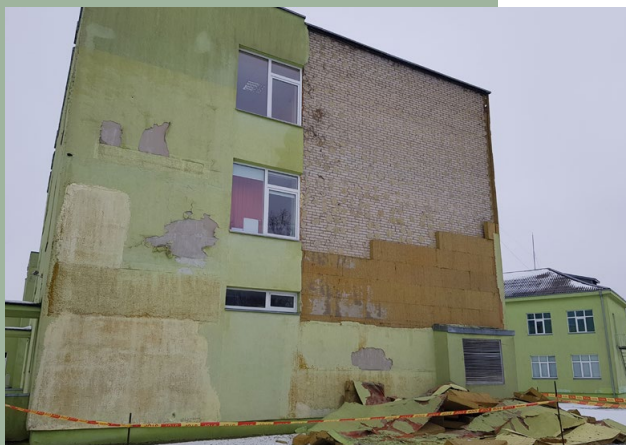
Fasadas prieš remontą
